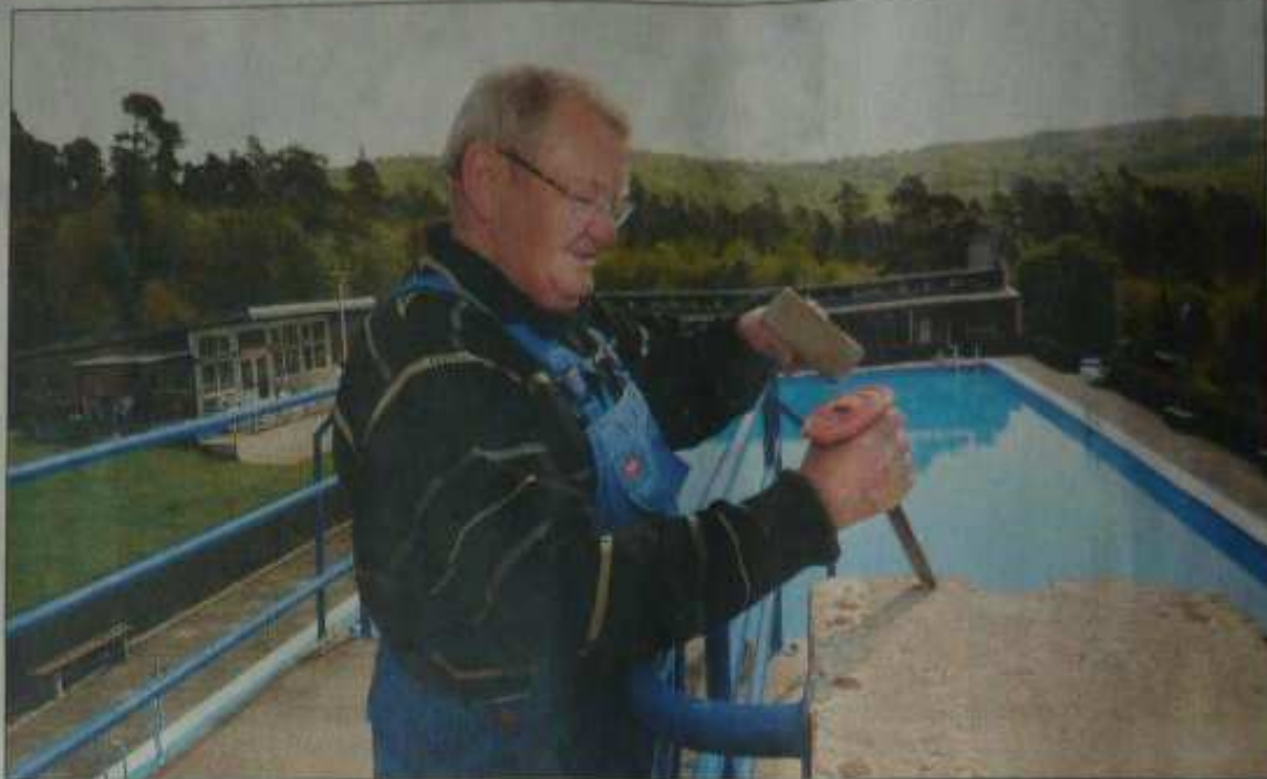
Bauruppleiter Harald Stahl legt letzte Hand auf dem Sprungturm an.
